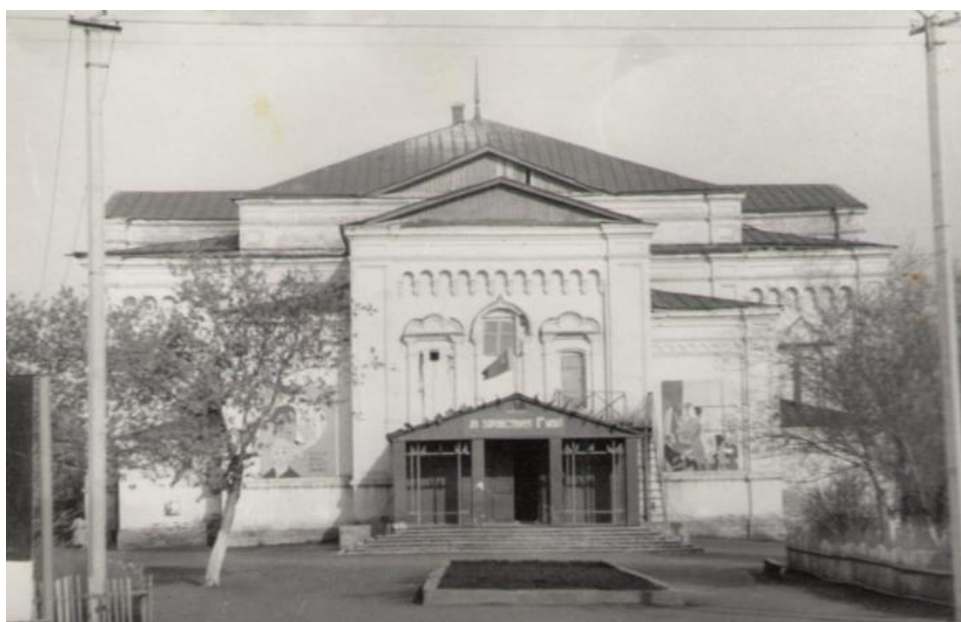
Фото здания храма - кинотеатр «Октябрь»
